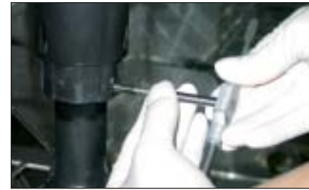
Abbildung 7: II. Schritt: M-6-Gewinde einschneiden.
